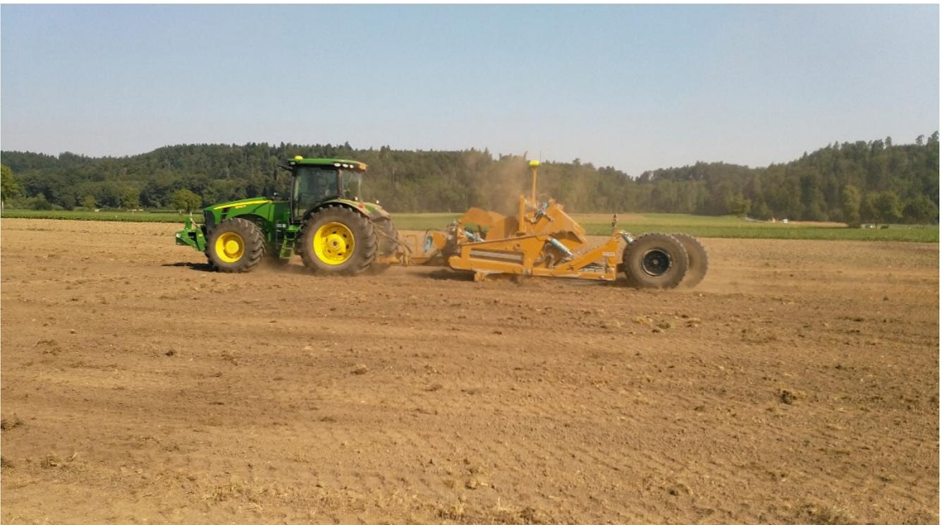
Abbildung 4: Feinnivellierung mit Scraper und Präzisions-GPS (RTK). (Foto vom 24.07.2019)
