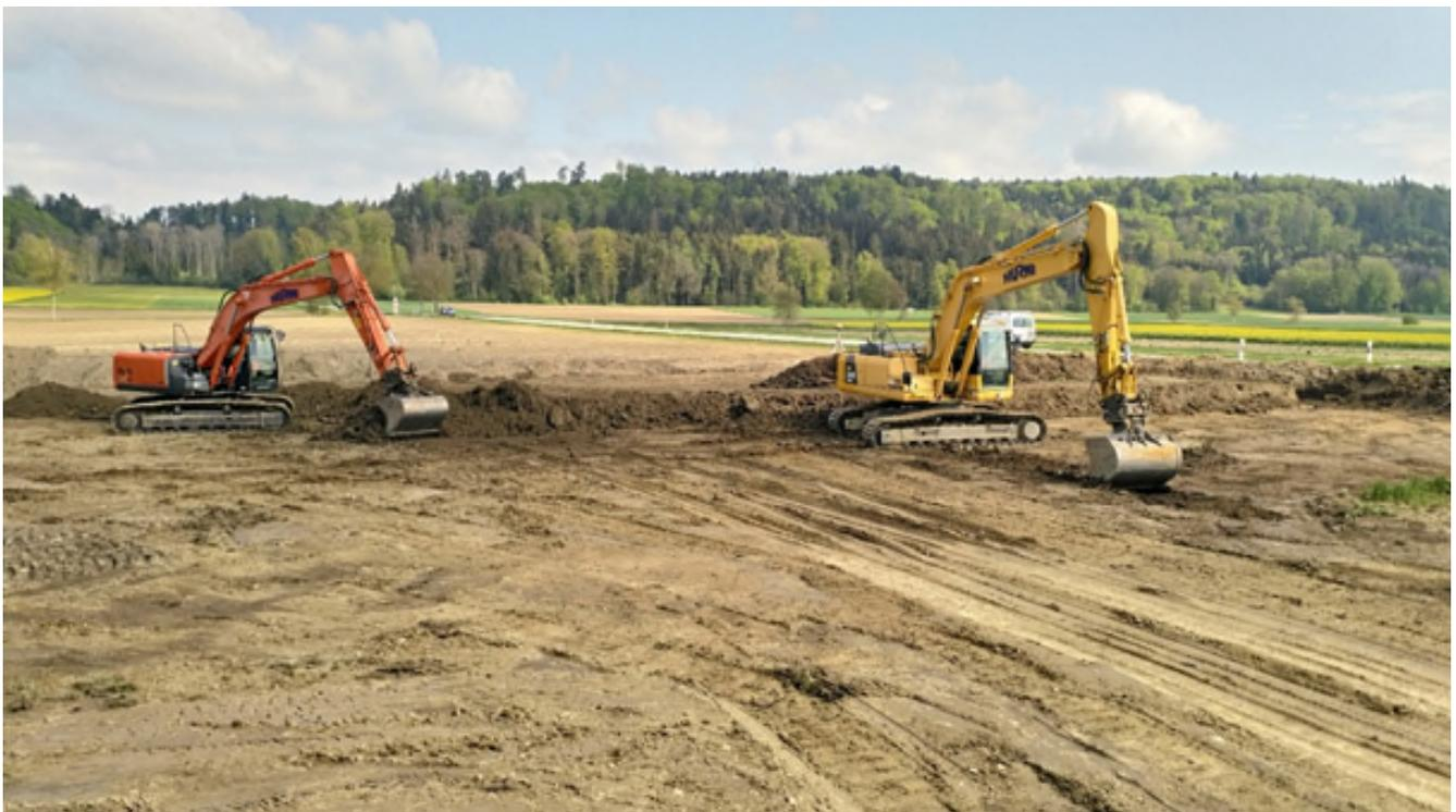
Abbildung 2: Terrainauffüllung mit Raupenbaggern und zugeführtem C- und B-Boden. (Foto vom 30.04.2019)
