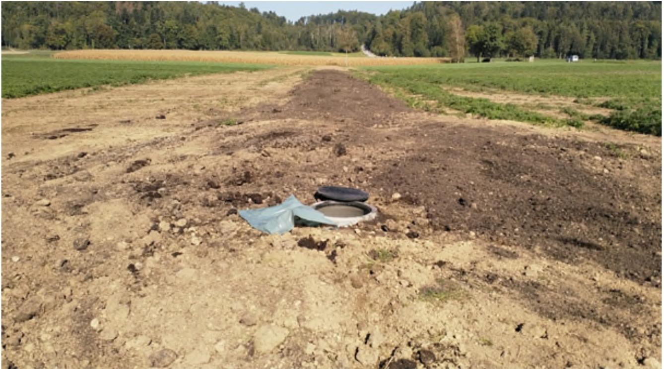
Abbildung 1: Neu erstellte Hauptleitung mit Kontrollschacht in der Streckenmitte. (Foto vom 28.09.2018)
