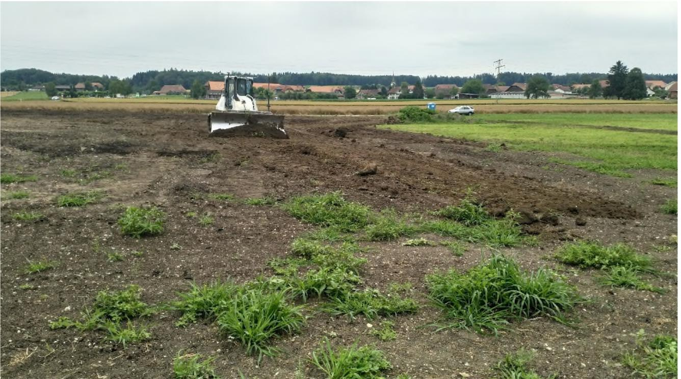
Abbildung 3: Anlegen A-Boden (Oberboden) mit GPS-gesteuerter Planierraupe. (Foto vom 11.07.2019)
