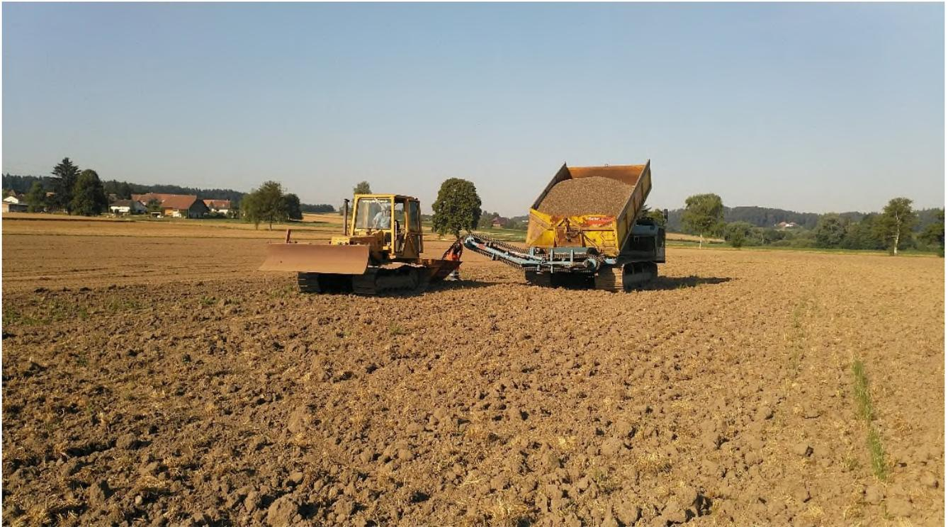
Abbildung 5: Feinentwässerung durch Einpflügen von Kiesschlitzten. (Foto vom 25.07.2019)
