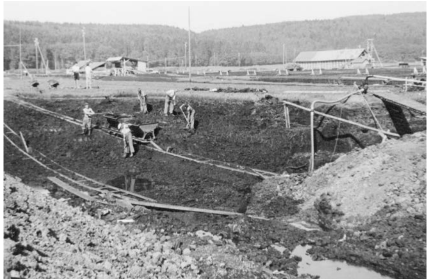
Abb. 4. Damit die bis fünf Meter dicke Torfschicht abgebaut werden konnte, musste im Wengimoos der Grundwasserspiegel mittels Pumpen abgesenkt werden (Photo ASP BE). Fig. 4. In order to be able to cut the up to 5 metre thick peat layer of the Wengimoos, the groundwater table had to be lowered with pumps (Photo ASP BE).
